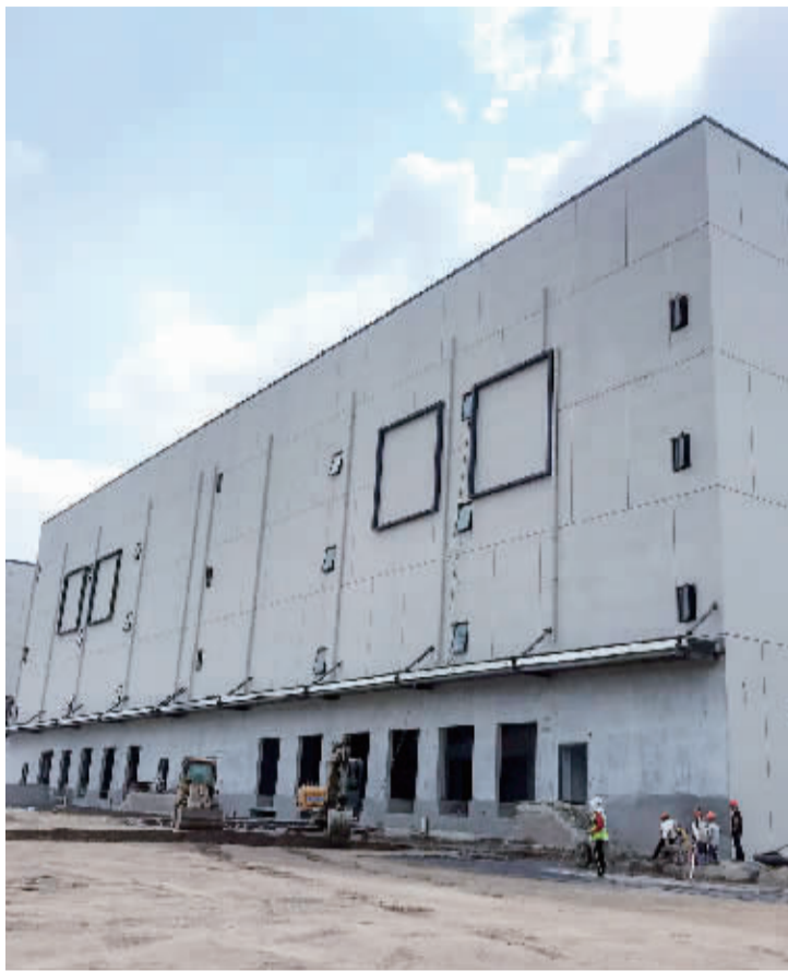
大型全温段冷库已进入收尾阶段。
