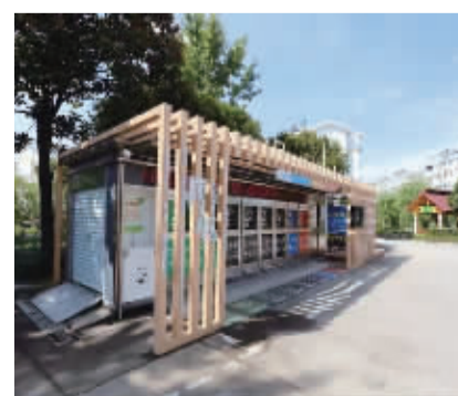
鄞州区下应街道湾底村“碳中和”小屋。
