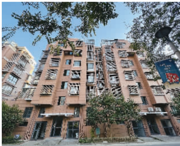
修缮后的红景佳苑小区外墙。记者 周科娜 摄
