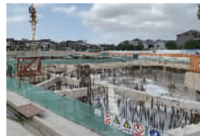
城湾幼儿园项目施工现场。
