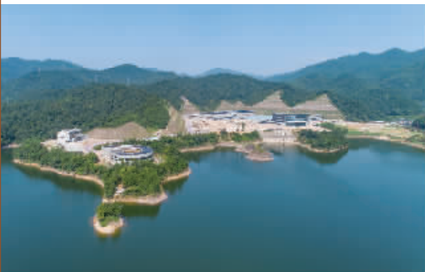
宁波最大的境外水库——钦寸水库。
