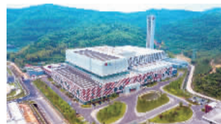
海曙区洞桥生活垃圾焚烧发电厂。
