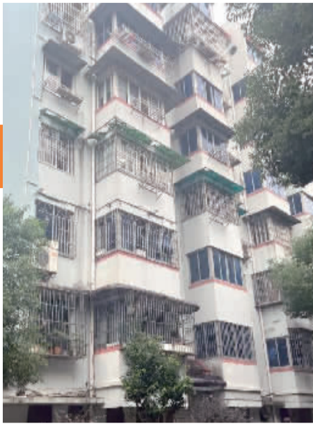
正在宁波产权交易中心官网上挂售的樟树街48弄23-26号房屋现状。记者 施文 摄
