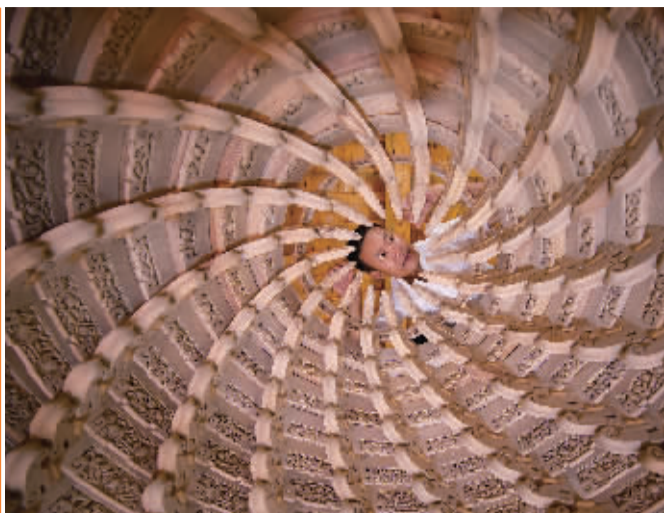
▶ 葛招龙正在查看戏台藻井部分的打造程度,藻井是整件作品中制作最难的部分,如花朵层层绽放。这自右向左盘旋而上的造型,由16层木质构件层层堆叠而成,一层一层盘成喇叭状。
