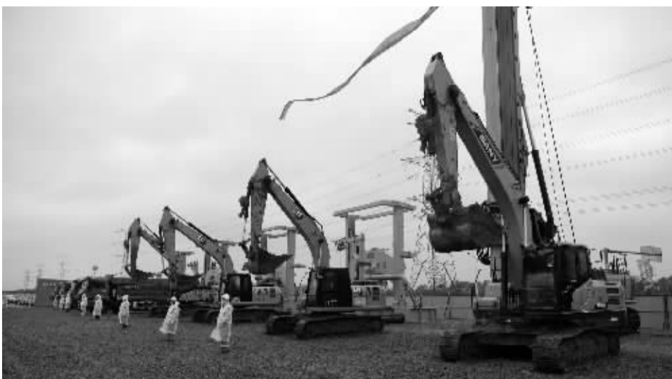
通苏嘉甬高铁浙江段开工仪式现场。记者 崔引 摄
