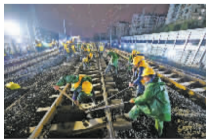
1200多名施工人员在铁路线上奋战。 记者 杨辉 摄
