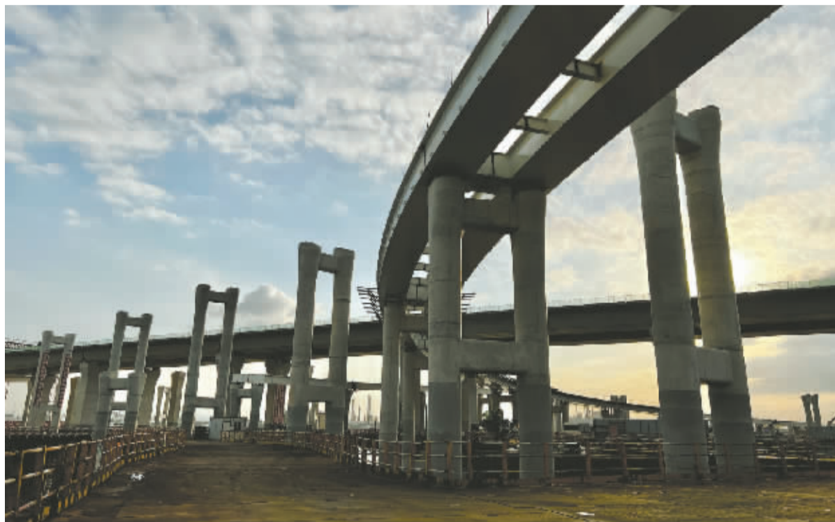
杭甬高速复线宁波段一期工程正在加速建设中。记者 崔引 摄
