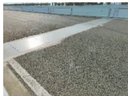
无缝式伸缩缝。
