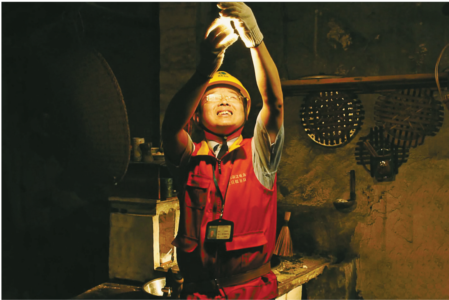
钱海军在慈溪市横河镇一位老人家中修电路。
