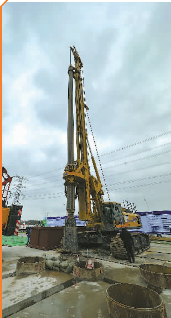
通苏嘉甬高铁全线首根桩基顺利开钻。 记者 范洪 摄
