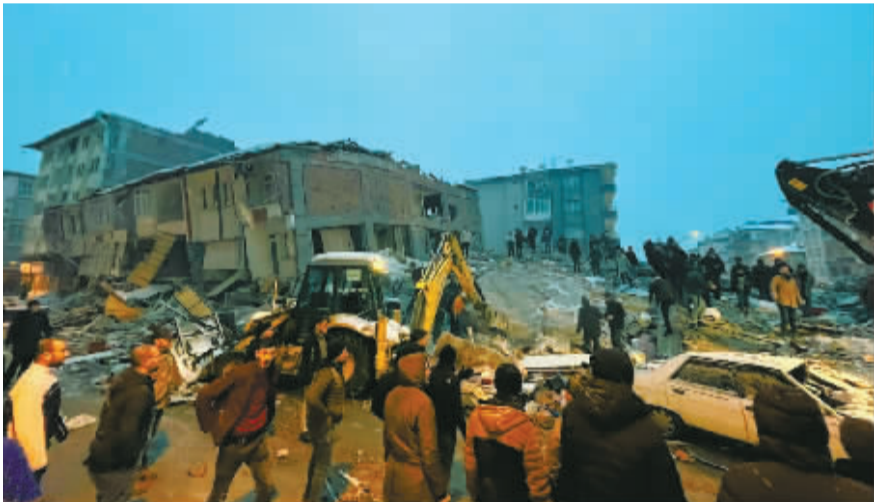
2月6日,人们聚集在土耳其马拉蒂亚一处倒塌的建筑附近。
