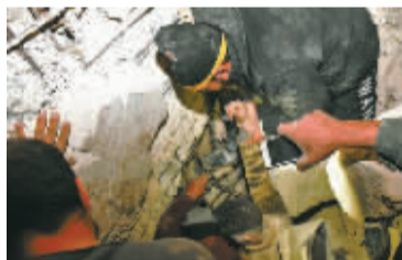
人们在叙利亚倒塌的建筑上救援。
