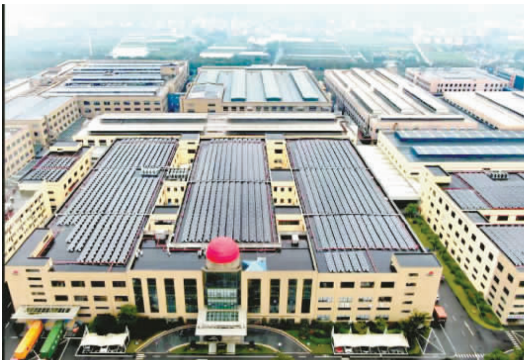
旭升股份的屋顶光伏板。
