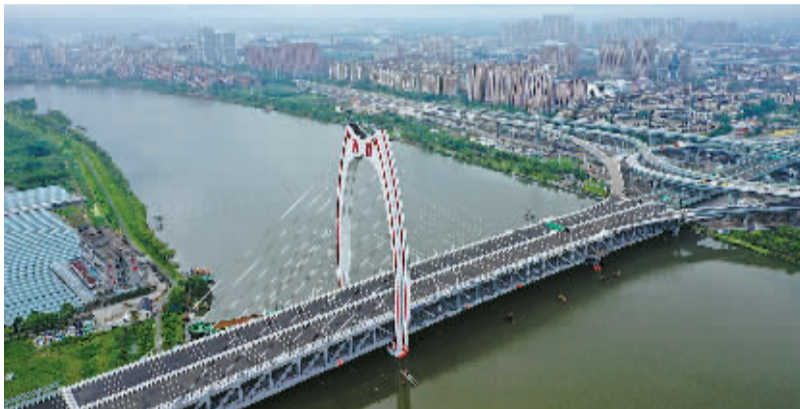
西洪大桥及接线工程。记者 杨辉 摄
