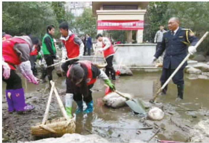
迪赛缘园小区喷水池改造现场。
