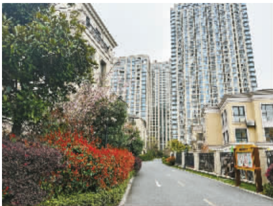
鄞州潘火香园一期小区。通讯员 章媛 摄
