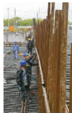
云飞路二期(邵渡路-广元大道)工程施工现场。记者 刘波 摄
