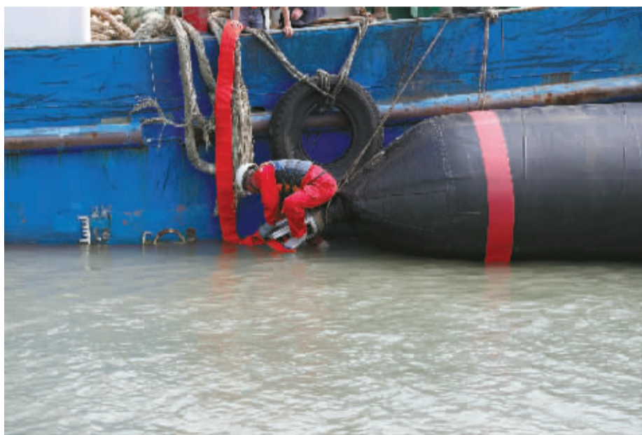
工作人员在安装、调试自承载橡胶气囊。
