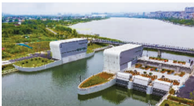
五江口闸及上游配套河道工程
