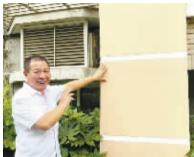
曾经空鼓的外墙,如今已经修缮一新。 记者 周科娜 摄
