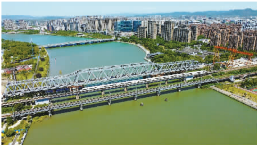
姚江铁路桥现状。前方2条为一二线,后方大铁桥为三四线。
