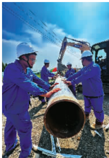
作业人员顶着高温施工。
