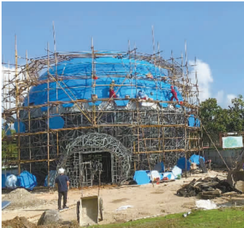
“黑科技”项目施工现场。
