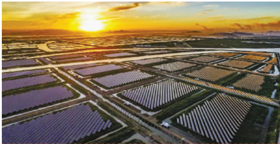
东方日升光伏项目。
