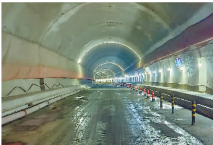
S309 荷梁线改建工程一期东岗隧道主洞贯通。
