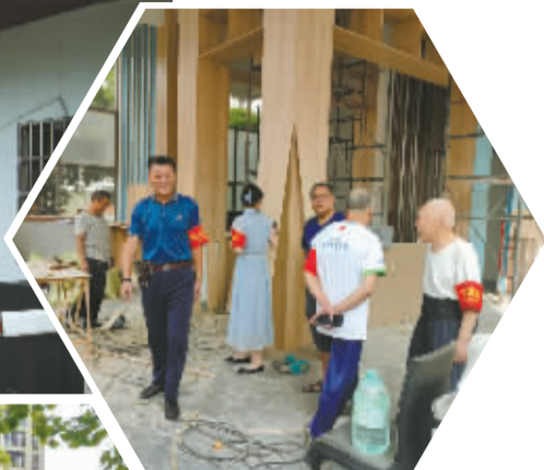
▲鄞州区东柳街道安居社区幸福苑小区居民自治监督小组正在对架空层改造工程进行监督。
