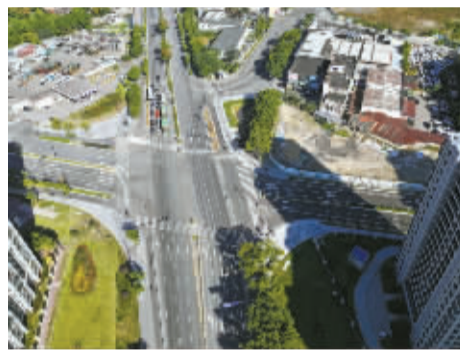
改造整治后的环城北路梅鹤路交叉口。
