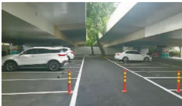
改造后的桥下空间。
