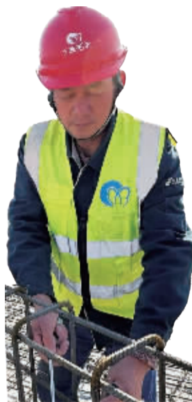
建设者正在作业。
