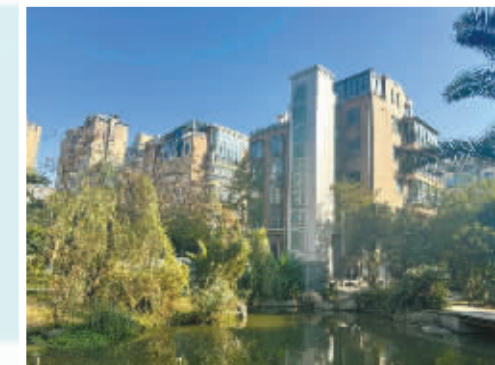
云河绿洲25幢1单元加装电梯。市房屋安全和物业管理中心供图
