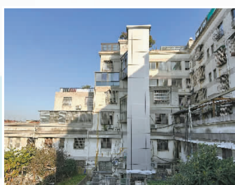
“车库换电梯”加装而成的电梯。市房屋安全和物业管理中心供图
