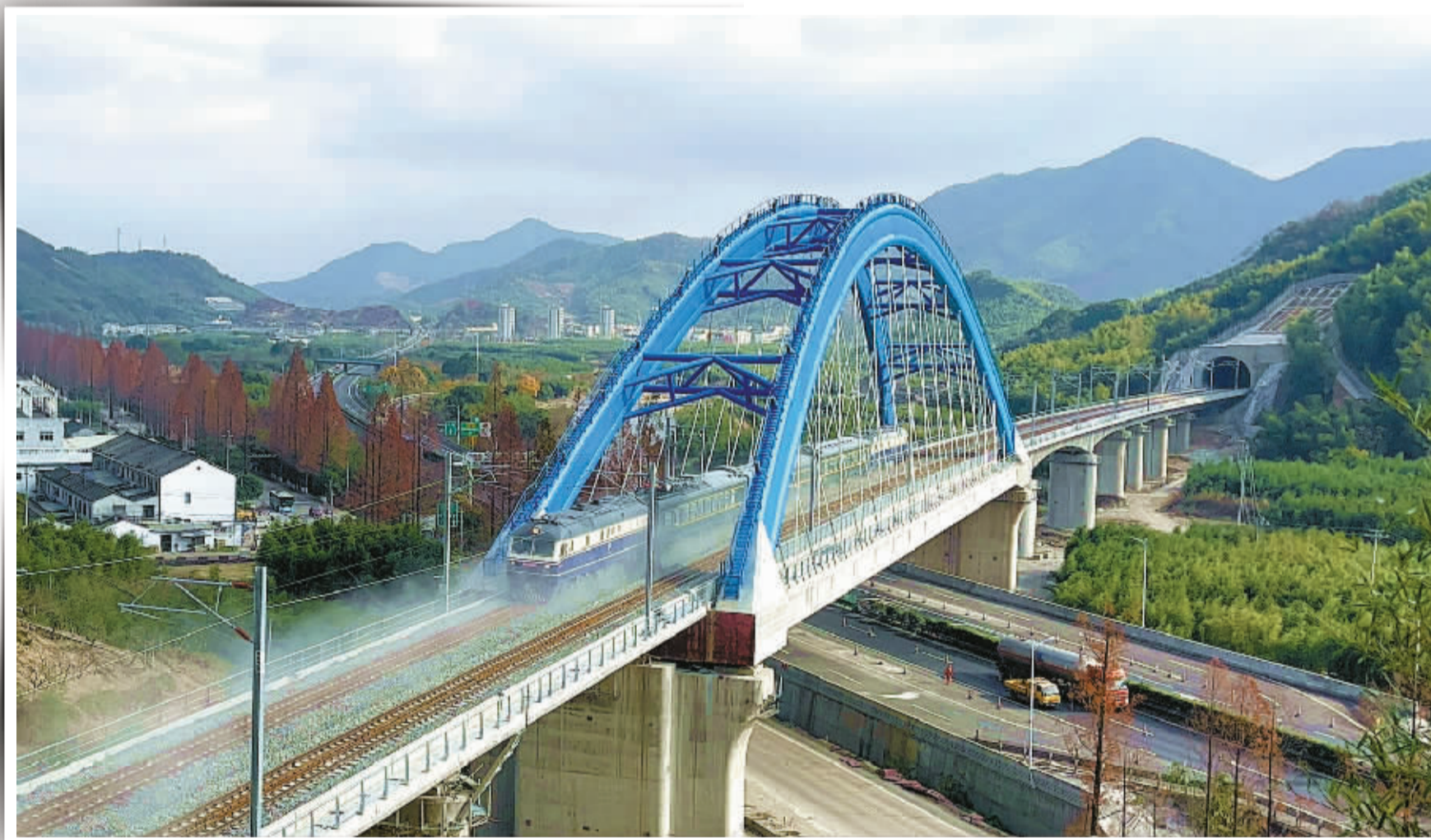
动态检测列车驶过溪口特大桥。 林海 摄
