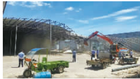
存在安全隐患的违建拆除中。
