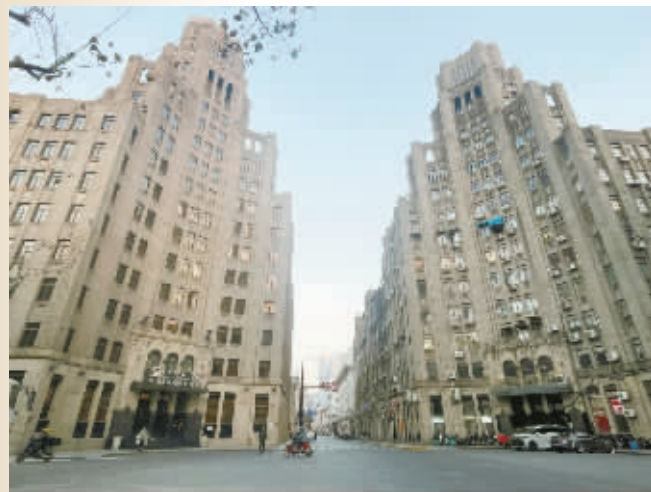
都城饭店（左）、汉弥尔登大楼（右，今福州大楼）均为新仁记营造厂承建。
