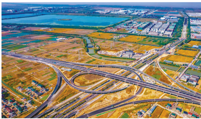
杭甬高速复线宁波段一期小曹娥互通。
