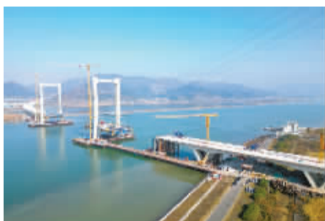
建设中的六横公路大桥(一期)。
