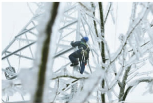
电力人员爬上铁塔查看覆冰情况。吕洪波 摄
