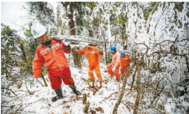
▲ 2月27日,经过9个小时抢修,国网宁海县供电公司支援余姚四明山地区的队伍,恢复朱曹、仰天湖等4个台区及低压线路送电。 胡云杰/摄
