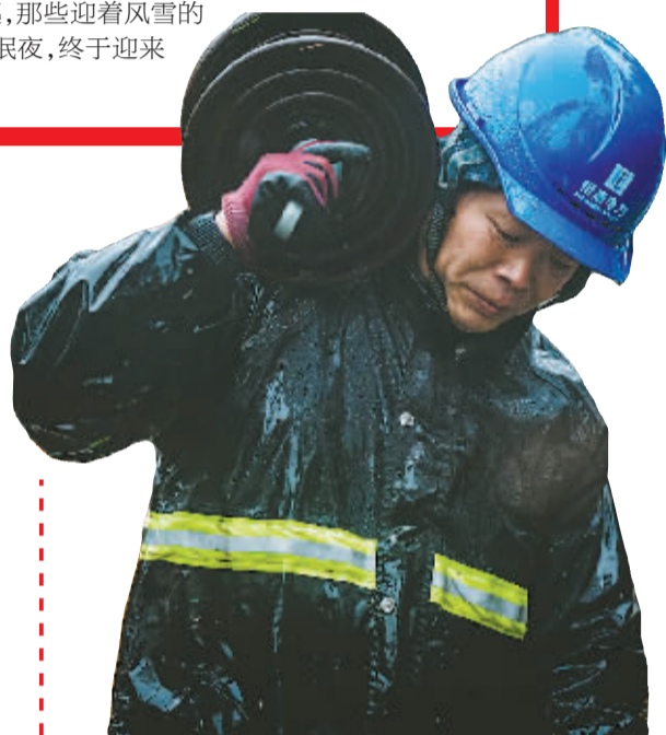
▲ 2月27日,国网宁波市奉化区供电公司支援余姚的队伍,在商茶线冒雨开展抢修作业。 盛家豪/摄
