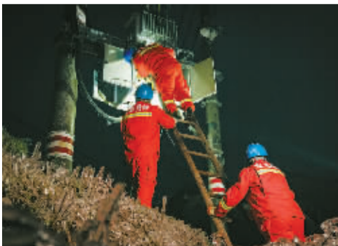
▲ 2月26日,国网宁波市鄞州区供电公司工作人员在岗后村连夜抢修,为当地居民接入生活用电。 洪浩哲/摄
