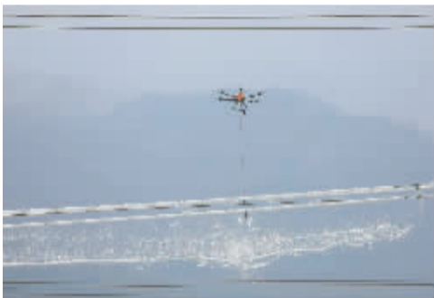
▲ 2月25日,在500千伏强明线防覆冰巡检现场,国网宁波供电公司首次利用无人机开展线路除冰,提升除冰效率,保障设备及人员安全。 王幕宾/摄
