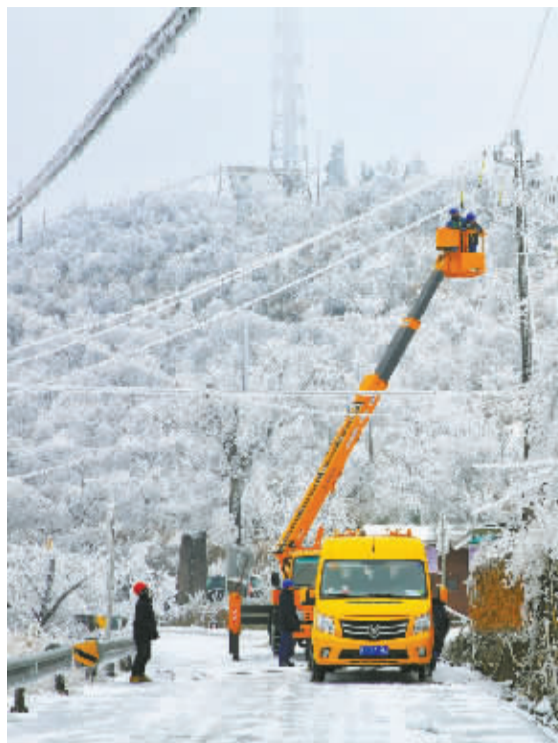
▲ 2月26日,国网宁波供电公司应急抢修人员利用登高车解决高处融冰难题,修复四明山杖锡村因覆冰导致的架空线路断线故障。 朱启东/摄
