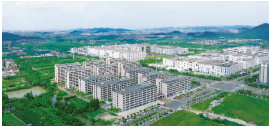
余姚市“光电小镇”特色产业风貌区项目。
