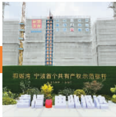
建设中的和樾湾项目。周科娜 摄
