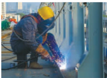
鄞州大道快速路(机场路-鄞横线)工程施工现场。
