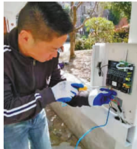
“充电驿站”工地,施工人员正在安装充电接口。
