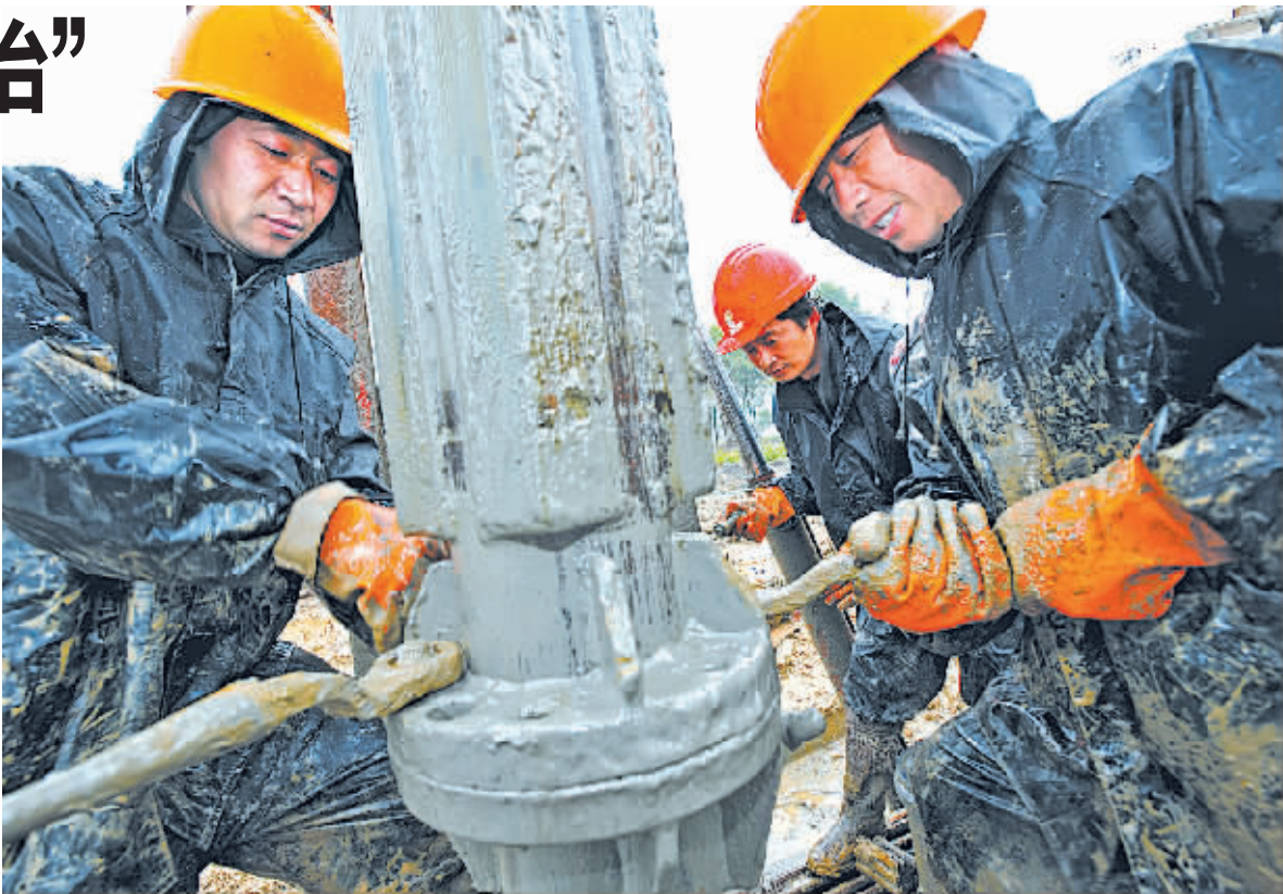
近日，施工人员正在奉化东江水系综合整治节点项目——东江大坝建设现场进行灌注作业。甬江防洪工程东江、剡江奉化段整治工程总投资近30亿元，是省重点A类项目。该工程完工后，仅奉化就能保护75个村、12.8万人口及1700多家企业在干流标准内免受洪水侵袭。（严龙 吴培维 张旭峰 摄）
