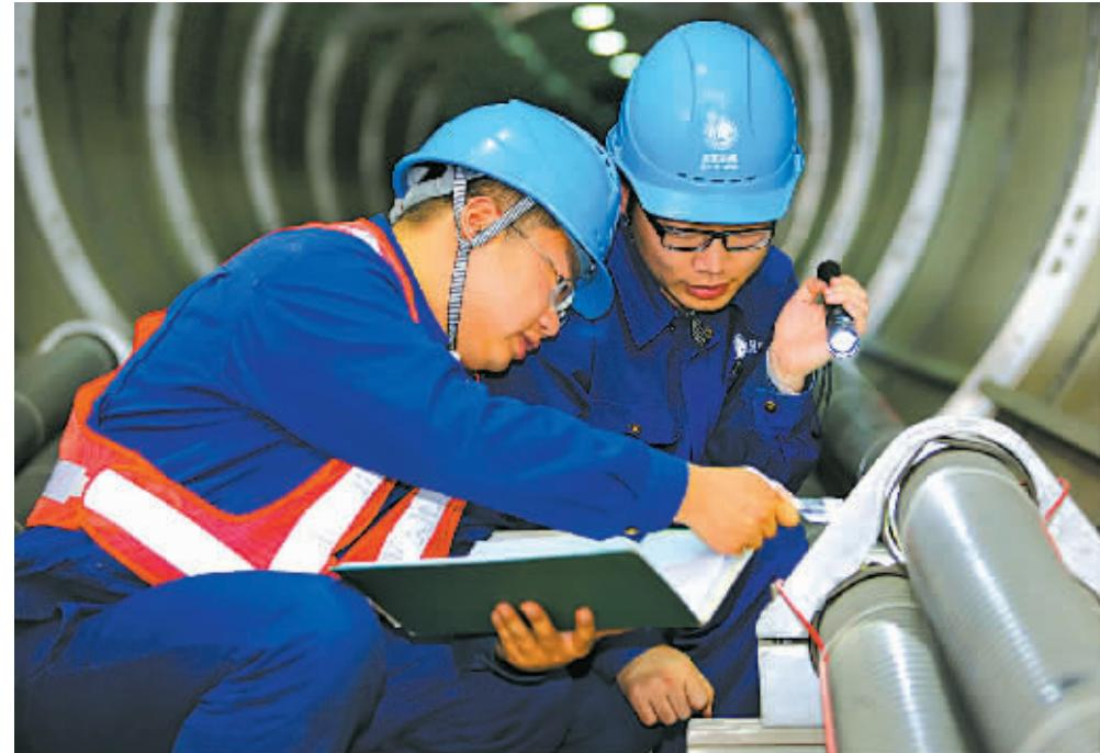
段距离就有贴着管道的不锈钢支架,分为上下4层。“电缆就固定在这些支架上,可容纳4回220千伏和4回110千伏线路。”一位电力负责人说。
