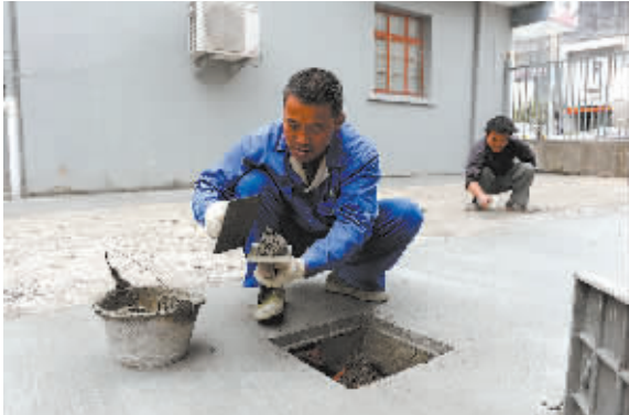
昨天,北仑新碶街道外洋小区外,施工人员进行填埋通信管道作业。(索向鲁 摄)
