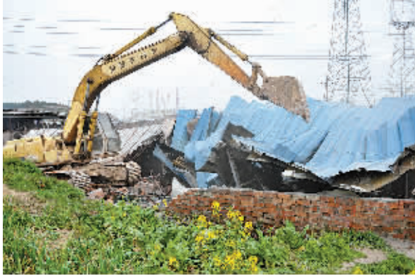
图为拆除现场。
