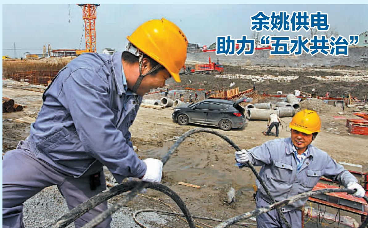
昨日，余姚市泗门供电所电力工人在姚江北排陶家路江泗门强排泵站工地安装电缆，为两台焊机提供电源。据了解，该项目是省、市及余姚市“五水共治”重点工程，余姚市供电公司选派技术精英进驻工地进行跟踪服务，全力保障施工用电。（胡建华 陈振初 刘文军 摄）
