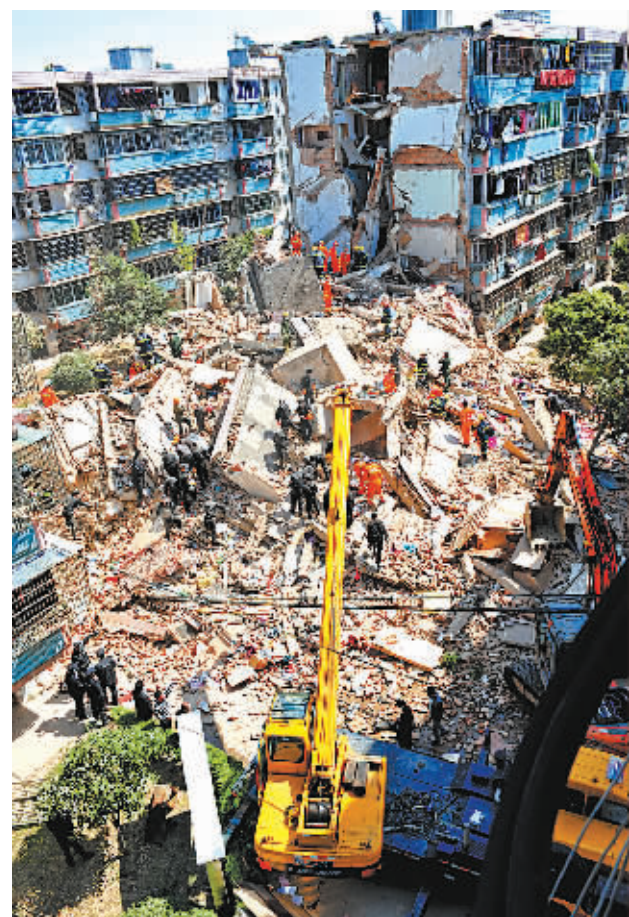
昨天上午，奉化市锦屏街道居敬小区29幢西侧房屋发生部分坍塌。（记者 严龙 李岩宏 摄）
